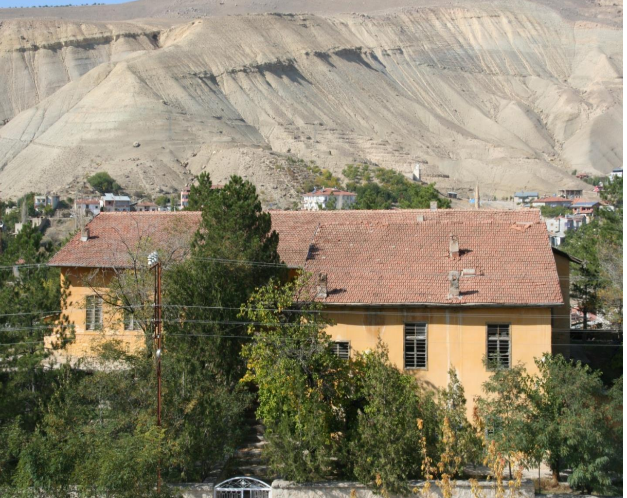
Okulun eski binası
